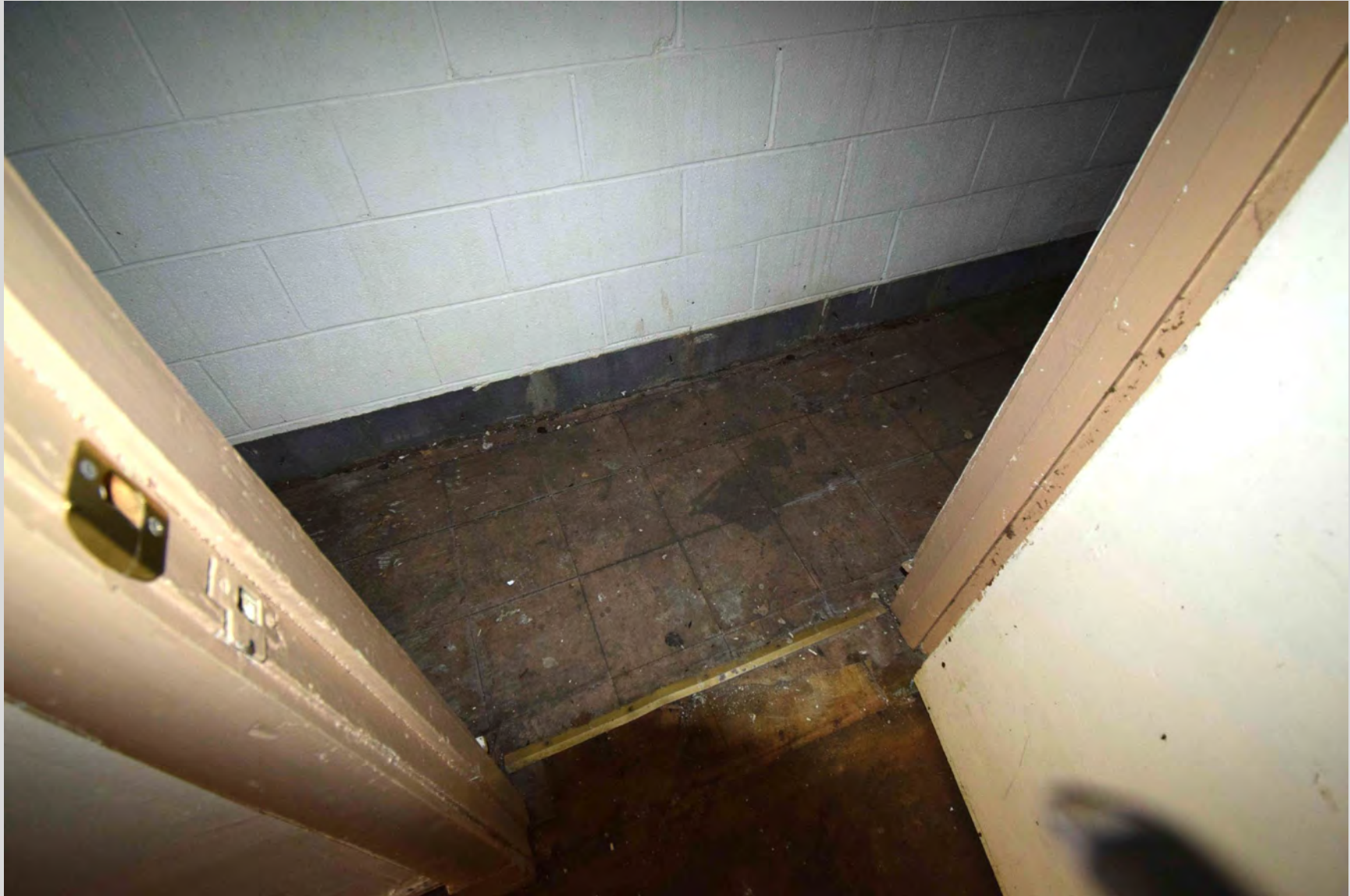
108-6194_Winslow_Hospital_2023_Main_Floor_original_vct_flooring_in_closet
